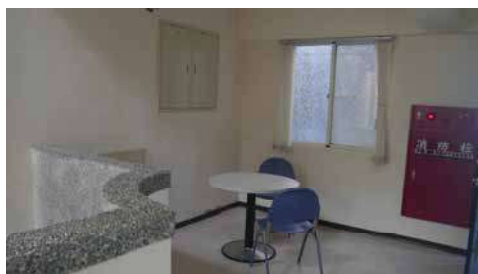
12.走廊底端封閉，採光不佳
