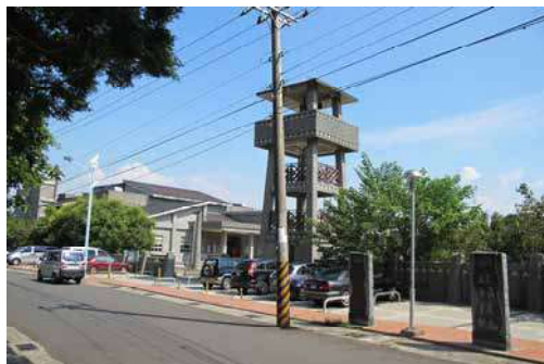
2、仁愛路原民中心主要入口樣貌
